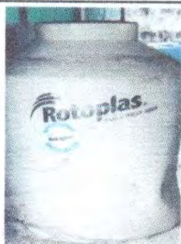
Fotografía 9 SUSTITUCION DE DEPOSITO DE AGUA 1100 LT
