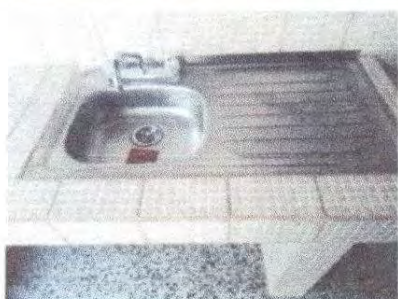
Fotografía 15 SUSTITUCION DE LAVATRASTOS (INCLUYE MEZCLADORA) EN ÁREA DE COCINA.
