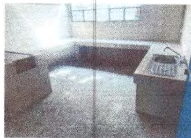
Fotografía 8 COLOCACION DE AZULEJO EN ÁREA DE COCINA.
