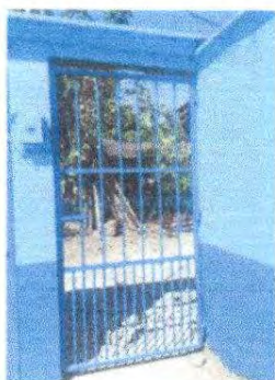
Fotografía 7 MANTENIMIENTO DE PORTON EN ENTRADA DEL ESTABLECIMIENTO.
