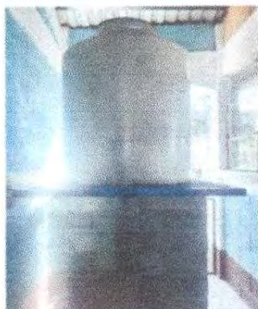
Fotografía 11 INSTALACIÓN DE ESTRUCTURA PORTANTE DE METAL PARA SOPORTE DEL DEPOSITO DE AGUA.
